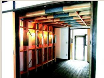
材 質：木材と鋼材のハイブリッド構造
