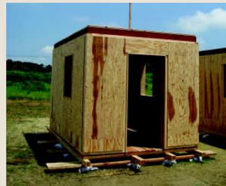
材 質：木製、但し、天井パネルは枠は鋼製
