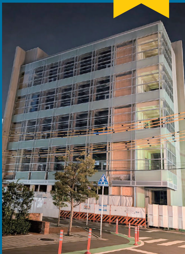
さいたま大宮 鍵利CLT BLDG.
