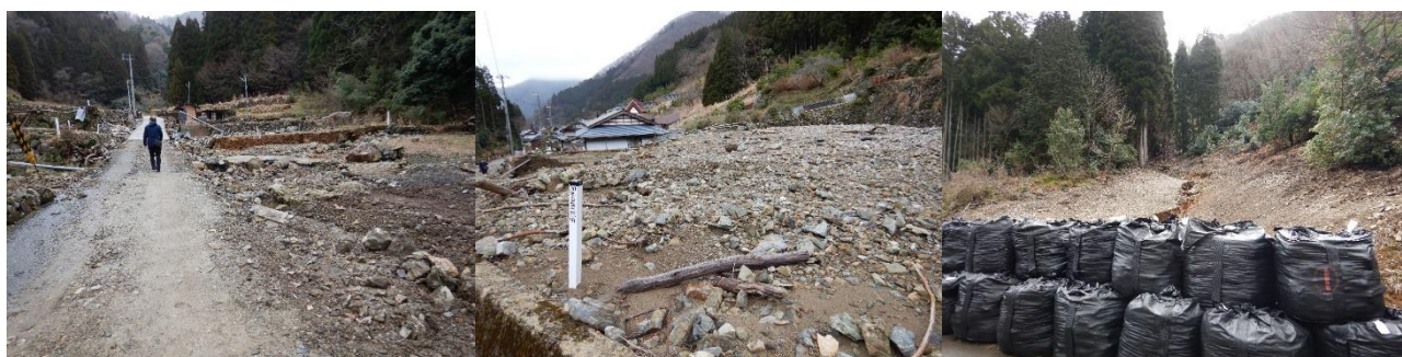
写真-1 平成 30 年 7 月豪雨における京都府船井郡京丹波町上乙見地区における土石流・がけ崩れによる被害
