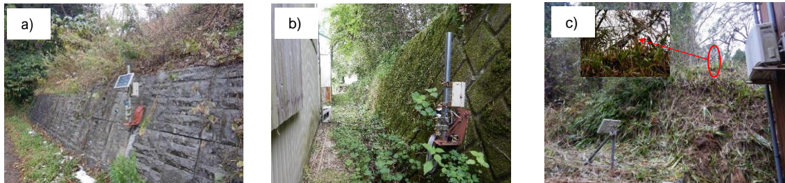
写真-4 POCKET による斜面の変形計測の様子，a) 農道沿いのブロック積み擁壁（③），b) 小学交体育館背面のブロック擁壁（⑤），c) 住宅背面の斜面（⑥）
