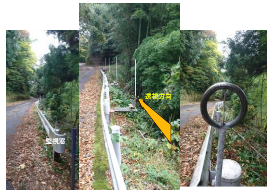
写真-1 「見通し棒」を用いた変形計測の様子
