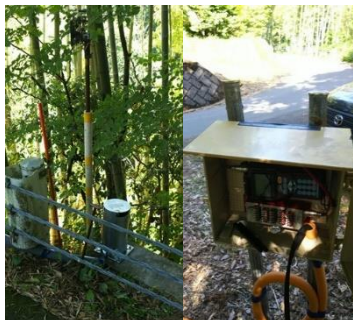
写真-7 傾斜計とデータロガー
