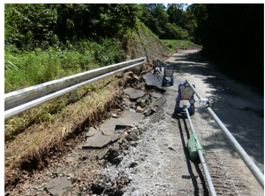
写真1 市道の被害の様子(2021.7.31.筆者撮影)
