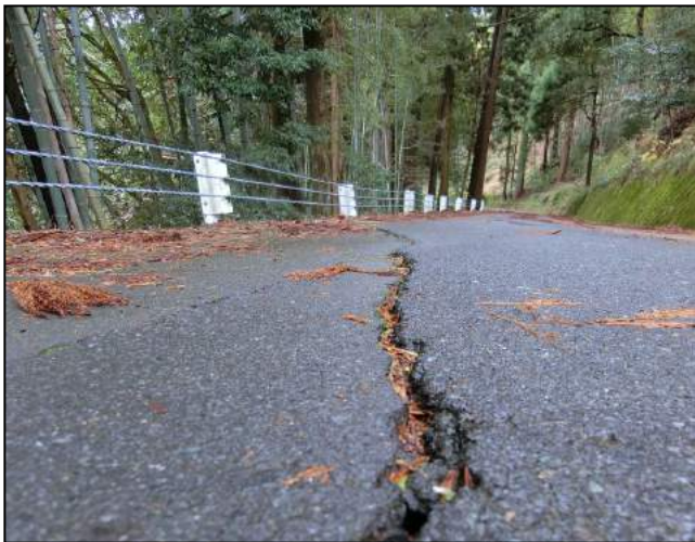
写真3 集落のアクセス路のひとつ (路面にはひび割れがあり、擁壁に損傷が見られる)
