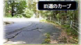
2019年12月17日および2020年12月4日の時点で道幅「5.683m」、しかし、2021年5月28日は「5.691m」、今回は「5.692m」でした7月末の豪雨による大きな変化は見られませんが、引き続き要注意です
