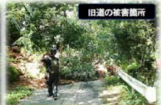
旧道の斜面崩壊箇所。竹林が路面にそのままへっぺてきています「見通し棒」(簡易観測機器)は、土砂によって吹き飛ばされてしまいました
