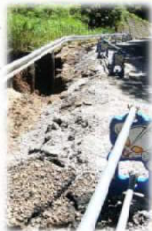
2019年12月17日および2020年12月4日の時点で道幅「5.683m」、しかし、2021年5月28日は「5.691m」、今回は「5.692m」でした7月末の豪雨による大きな変化は見られませんが、引き続き要注意です
