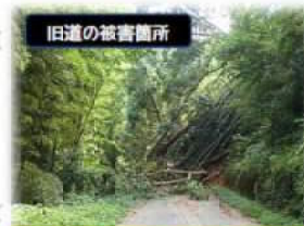
旧道の斜面崩壊箇所。竹林が路面にそのままへっぺてきています「見通し棒」(簡易観測機器)は、土砂によって吹き飛ばされてしまいました
