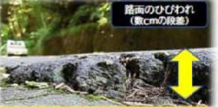
2019年12月17日および2020年12月4日の時点で道幅「5.683m」、しかし、2021年5月28日は「5.691m」、今回は「5.692m」でした7月末の豪雨による大きな変化は見られませんが、引き続き要注意です
