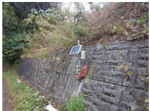
農道沿いのブロック擁壁に設置したPOCKET
